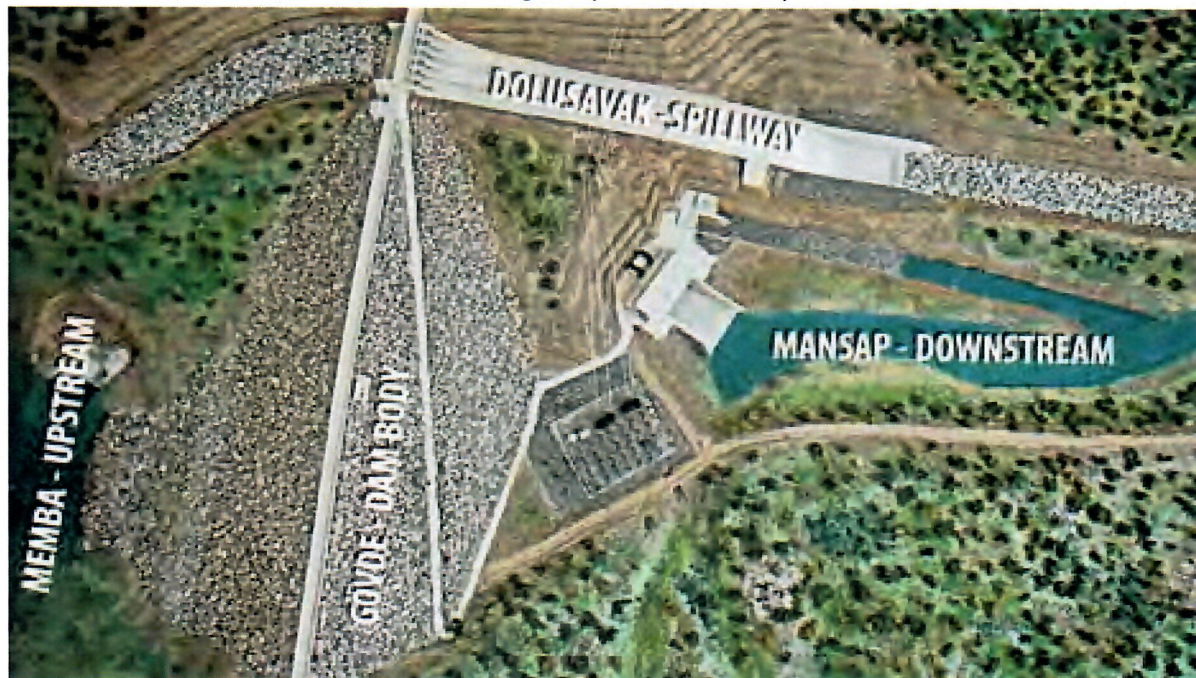
Obrázek č 3 rekonstrukce tělesa hráze, energetických tunelů a bezpečnostního kanálu
