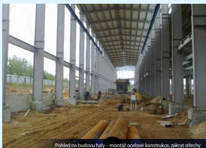
Pohled na budovu haly – montáž ocelové konstrukce, zákryt střechy
