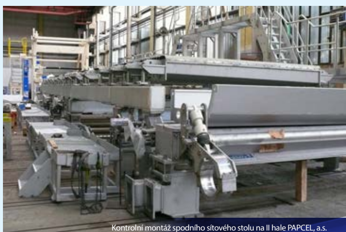
Kontrolní montáž spodního síťového stolu na II hale PAPCEL, a.s.
